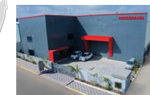
RINGSPANN Power Transmission India Pvt. Ltd., Indien
