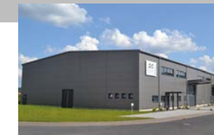
RINGSPANN StS GmbH, Deutschland Werk Präzisionskupplungen
